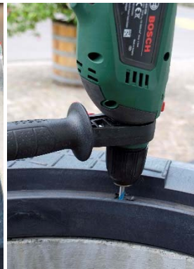
Foto 5 - 9 Befestigungsset M mit 2 expansionsfreien Lastankern. Mit Spezialbohrer ohne Schlaghammer Löcher für Lastanker bohren (s.h. Datenblätter). Bolzenanker auf entsprechende Setztiefe mit Hammer einschlagen, Muttern und Rahmen wieder entfernen. Zwecks Abdichtung Falz mit Brunnenschaum (z.B. Sika-Boom D) Ausschäumen. Rahmen auf die 2 Bolzenanker aufsetzen und mit U-Scheiben und Muttern anschrauben.
