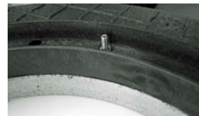
Foto 5 - 9 Befestigungsset M mit 2 expansionsfreien Lastankern. Mit Spezialbohrer ohne Schlaghammer Löcher für Lastanker bohren (s.h. Datenblätter). Bolzenanker auf entsprechende Setztiefe mit Hammer einschlagen, Muttern und Rahmen wieder entfernen. Zwecks Abdichtung Falz mit Brunnenschaum (z.B. Sika-Boom D) Ausschäumen. Rahmen auf die 2 Bolzenanker aufsetzen und mit U-Scheiben und Muttern anschrauben.
