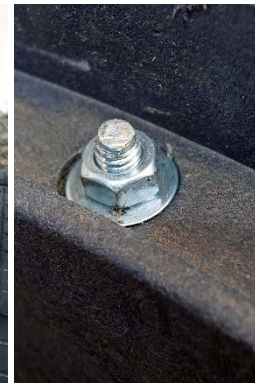
Foto 5 - 9 Befestigungsset M mit 2 expansionsfreien Lastankern. Mit Spezialbohrer ohne Schlaghammer Löcher für Lastanker bohren (s.h. Datenblätter). Bolzenanker auf entsprechende Setztiefe mit Hammer einschlagen, Muttern und Rahmen wieder entfernen. Zwecks Abdichtung Falz mit Brunnenschaum (z.B. Sika-Boom D) Ausschäumen. Rahmen auf die 2 Bolzenanker aufsetzen und mit U-Scheiben und Muttern anschrauben.
